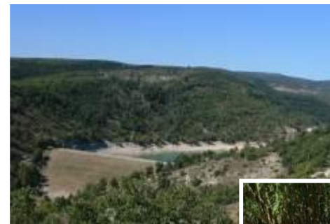
Barrage de la retenue de la Laye
