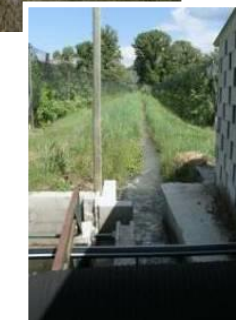
Canal d'irrigation sur le Lagneux
